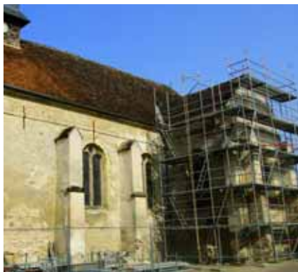
Rénovation de l'église Saint Saturnin : les travaux ont démarré en février
